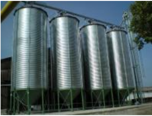
Рисунок 2 – Цилиндрические силоса для хранения с конусным дном
