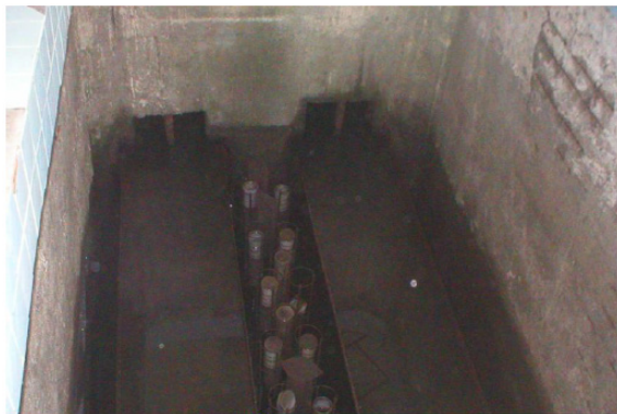
Рисунок 3 - План установки аэраторов в коридоре для биологической очистки
